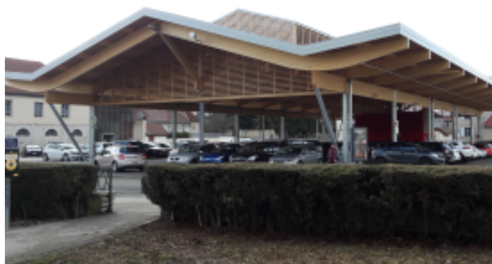
Halle couverte de la commune de Pontarlier (crédit photo : Fibois BFC).
